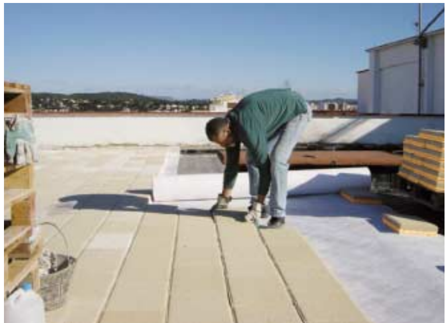
Rehabilitación de cubierta. Lastrado con Polyfoam Losa
