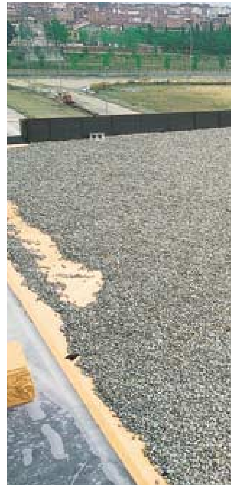
Cubierta invertida. Acabado con grava
