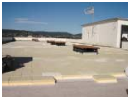
Acabado con Polyfoam Losa
