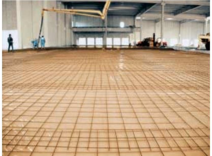
Suelo cámara frigorífica previo al vertido del hormigón
