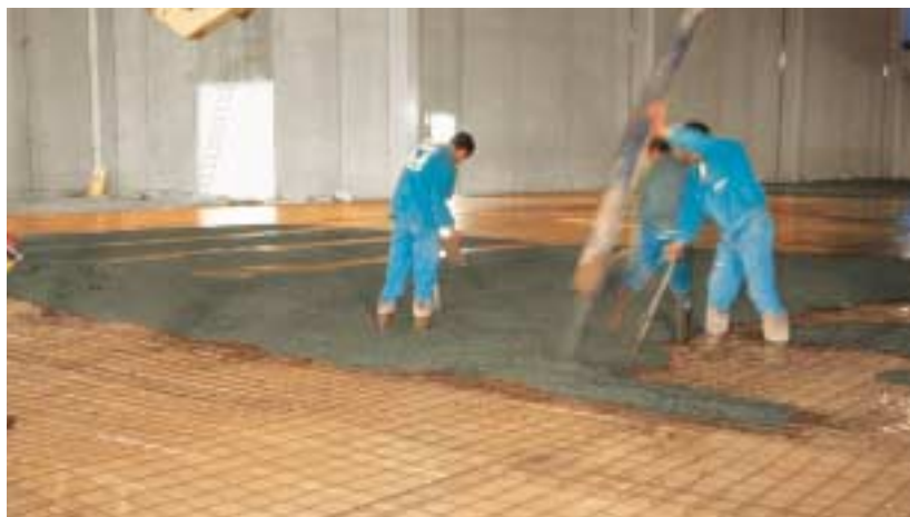
Instalación losa de hormigón
